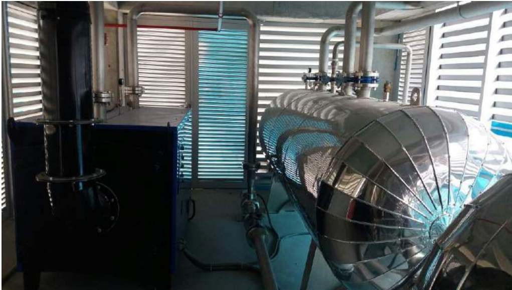
Ilustración 1 Caldera Kastor con tanque acumulador en recinto de hotel.
