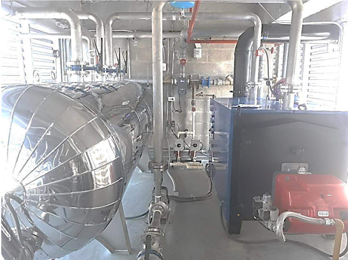
Ilustración 3 Caldera Kastor con quemador Riello instalada con acumulador de agua en espacio de hotel.
