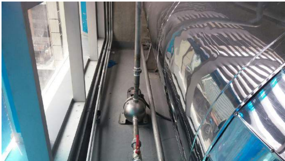
Ilustración 2 Tanque acumulador equipado con bomba para suministrar agua a la caldera.
